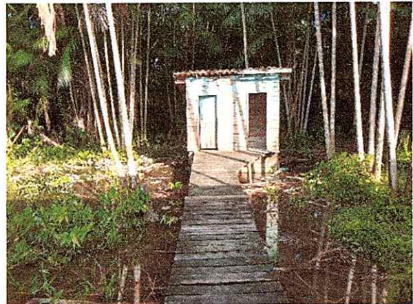
Figura 4 – Banheiro (Fonte SEMED)
