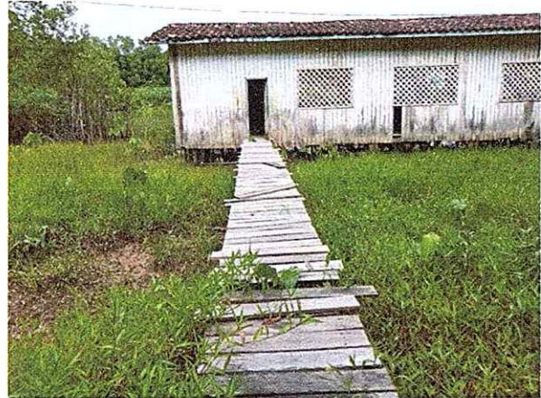
Figura 12 – Ponte de acesso ao banheiro (Fonte SEMED)
