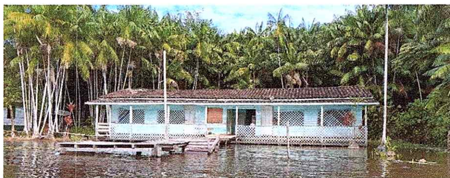
Figura 1 - Fachada da escola quase alagada (Fonte SEMED)
