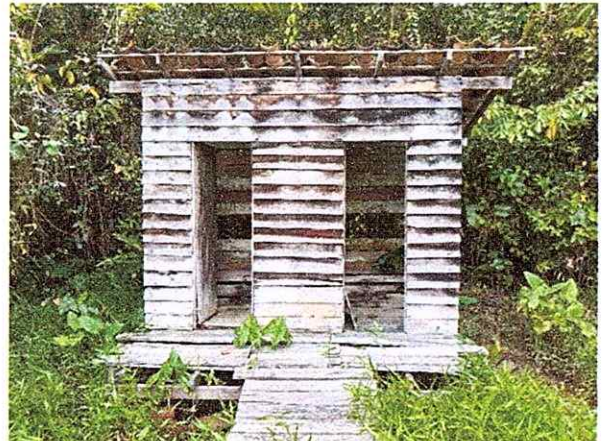
Figura 15 – Banheiro (Fonte SEMED)
