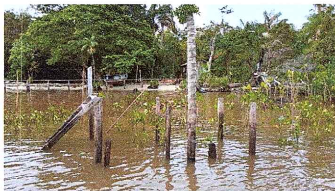
Figura 2 – Estacas remanescentes da antiga ponte (Fonte SEMED)
