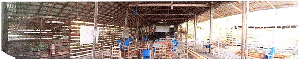
Figura 4 - Vista interna do barracão improvisado - Ilha do Cai (Fonte SEMED)
