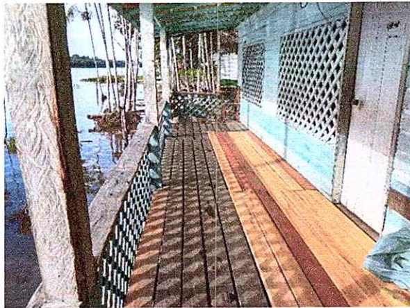
Figura 7 – Piso da passarela (Fonte SEMED)
